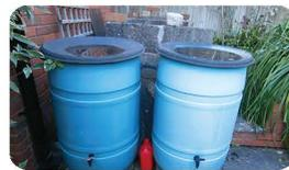
**FACILIDADES DE COLECCIÓN EN EL SUBSUELO, CISTERNAS, O BARRILES DE LLUVIA** el capturar agua de lluvia puede ayudar a reducir la cantidad de agua que corre hacia la calle, los canales de drenaje y tuberías. En adición, el agua de lluvia almacenada puede utilizarse para irrigar plantas y reducir el consumo de agua potable.
