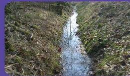
**“DICHE”/ZANJA** es un canal de vegetación expuesta que permite mover el agua de un punto a otro. Generalmente se utiliza en áreas menos pobladas, donde el flujo de agua por encima de la superficie se puede acomodar con mayor facilidad (áreas rurales).
