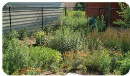
**JARDINES DE LLUVIA** es una depresión poco profunda, que están diseñadas para capturar las escorrentías de aguas pluviales de su techo, entrada de auto, y banquetas. También conocidos como estanques de biofiltración, los jardines de lluvia no están diseñados para retener agua pero para absorberla y filtrar los contaminantes mientras percola el agua en el suelo.
