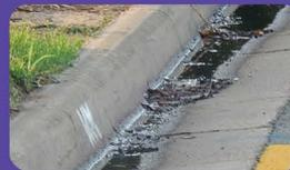
**CUNETA** canal de drenaje pavimentada.
